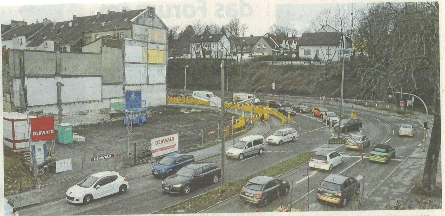
Der Übergang von der Faßstraße zur Willem-van-Vloten-Straße ist seit einigen Wochen in Richtung Hörde ein weiteres Nadelöhr. Das Unternehmen Derwald hat hier zwei Gebäude abgerissen und baut neue Wohnungen. RN-FOTO GUTH
